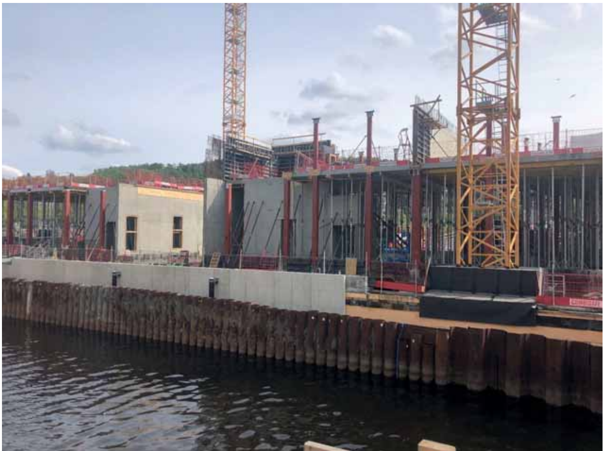
Byggeplass for felt B8a ved Bispekilen.
