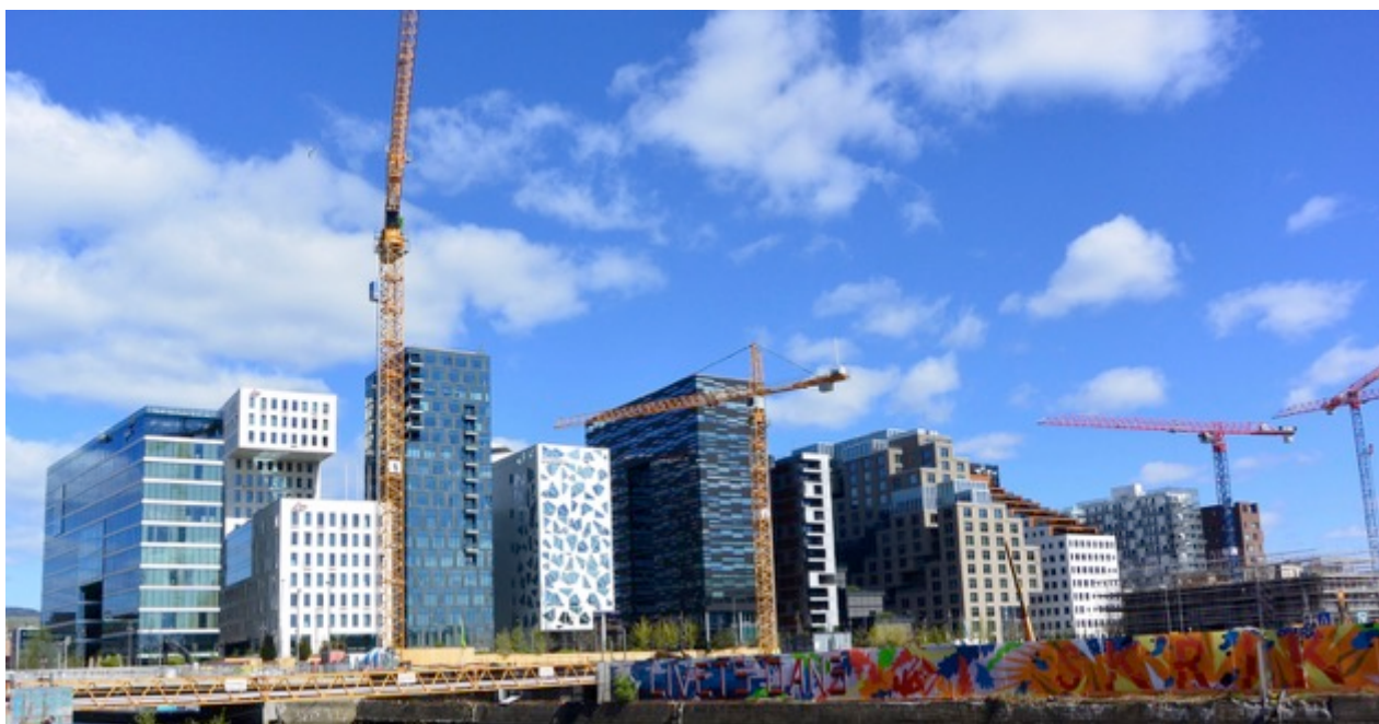
Operakvarteret med byggejerdet til Munch Brygge i forgrunnen
