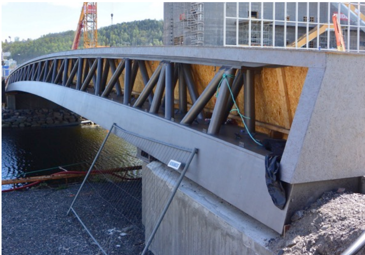
Ny bro over Akerselva til Munchmuseet er på plass. Det ble iverksatt tiltak for å ikke forurense sedimenter under bygging av brua
