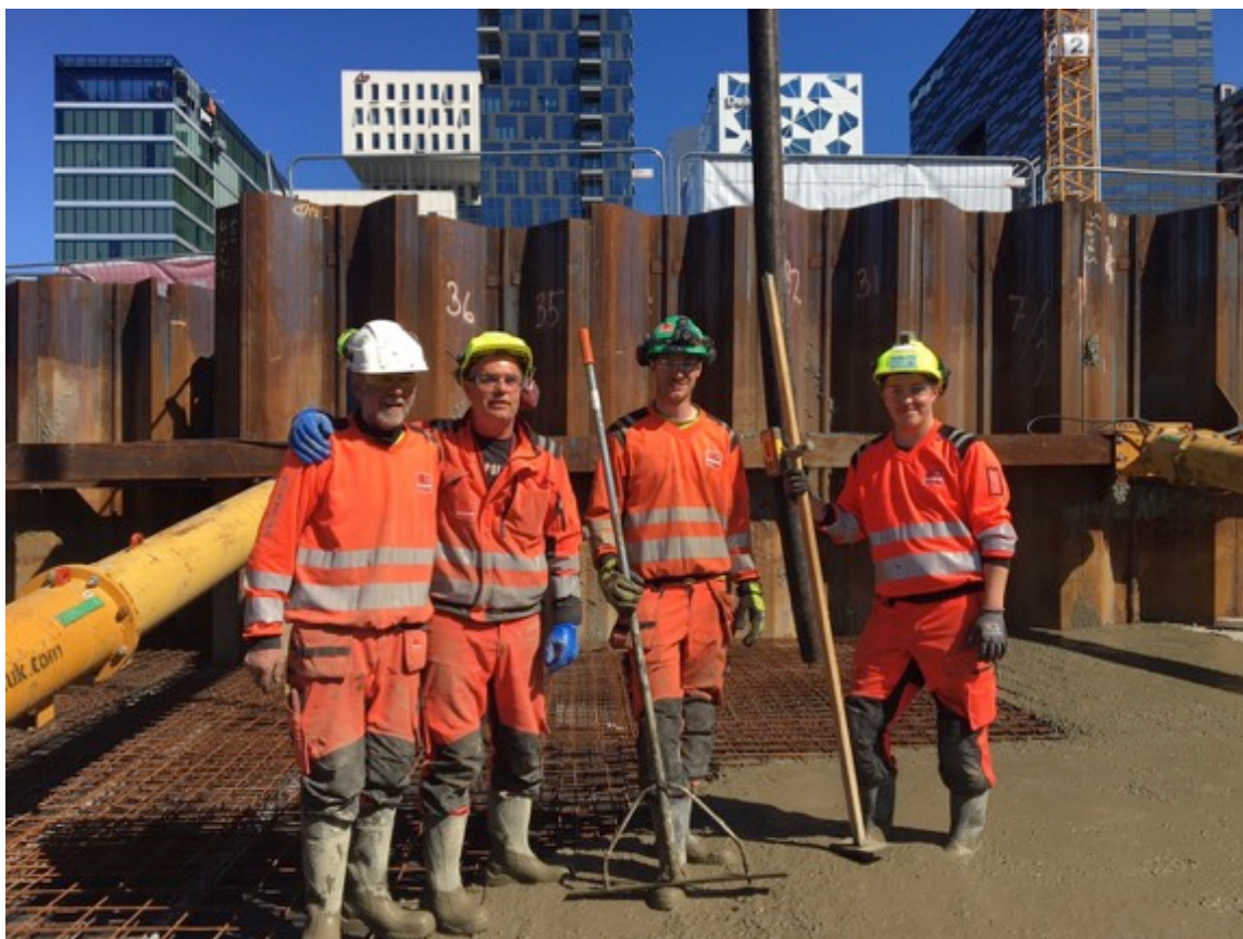
Støping av dekke på Munch Brygge, felt B4
