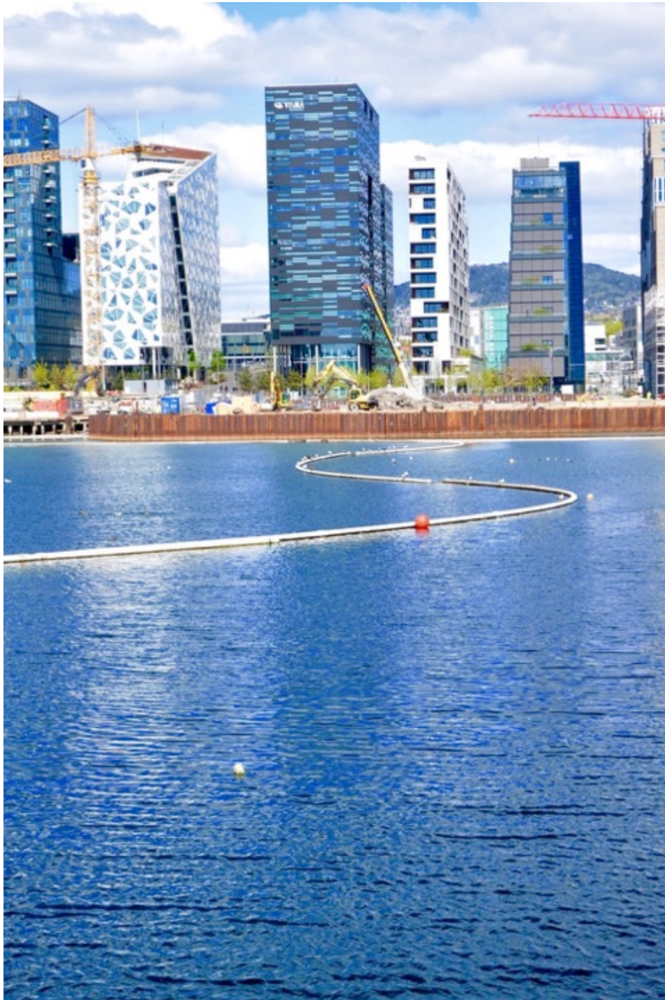
Siltgardin i Bispevika. Gardinen henger i overflaten og strekker seg ned til bunnen. Den hindrer partikkelspredning
