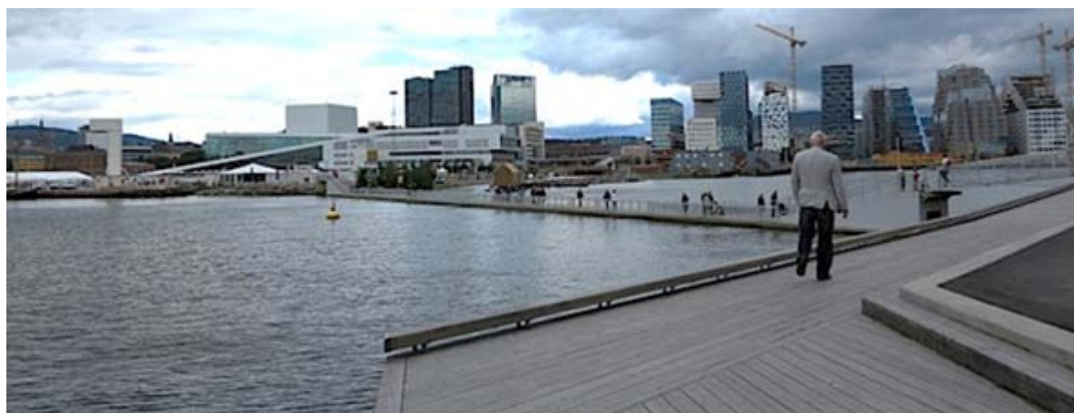
Midlertidig gangbro mellom Operaen og Sørengutstikkeren. Sjøbunnen i området er ren etter omfattende opprydning.
