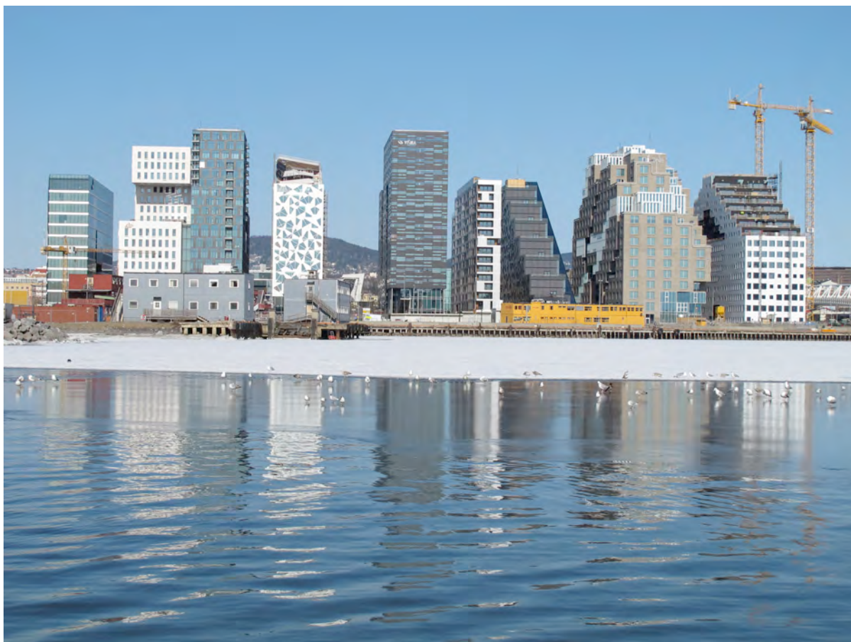
Opera Kvarteret sett fra sjøen. Lydisolerte vinduer i støyutsatte fasader.
