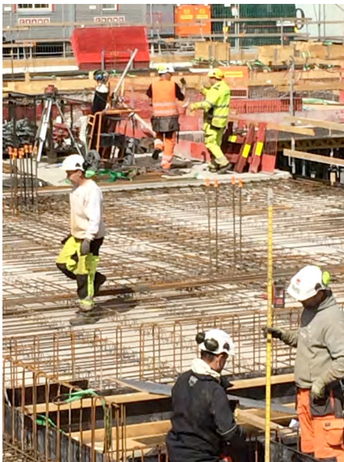
Arbeid med dekker på byggefelt D1-a. Armeringsjern med høy resirkuleringsgrad.
