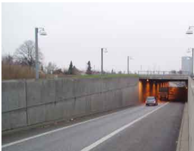
Belysning ved tunnelopkørsel/-nedkørsel
