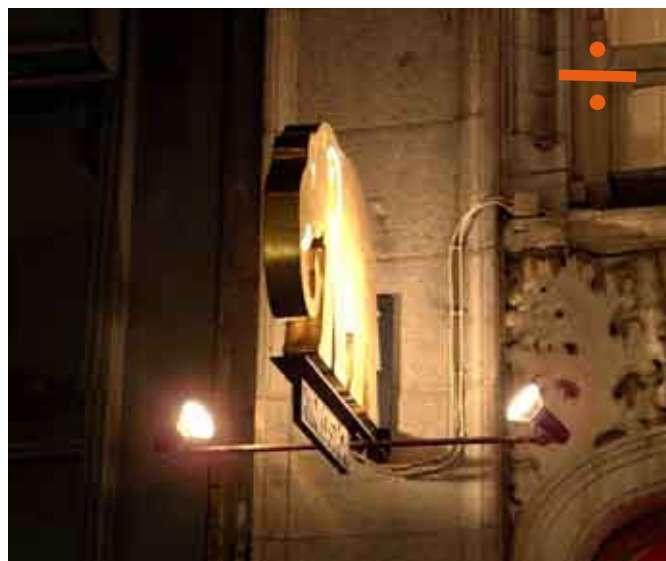
En meget almindelig, men dårlig måde at lyssætte et skilt på.
