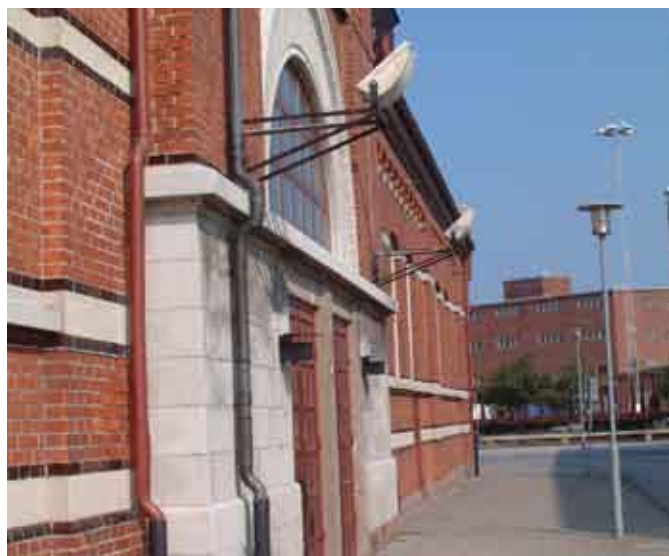
Dårligt planlagt facadebelysning
