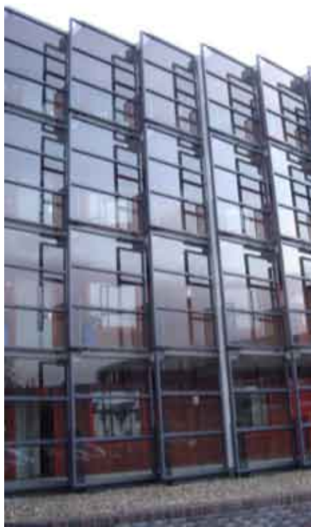
Fasade som regulerer passiv oppvarming og naturlig ventilasjon
