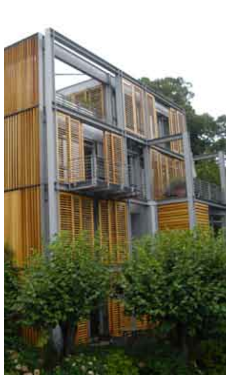
Solavskjerming av tre regulerer oppvarming og nedkjøling uten å bruke energi.
