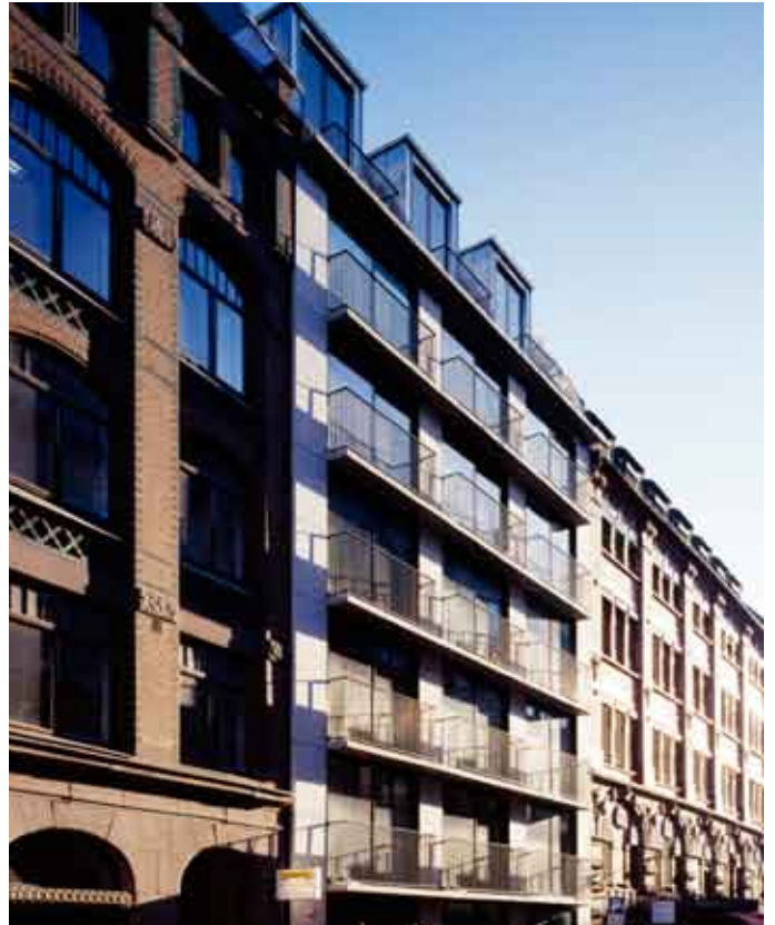
Skippergt 12, nytt boligbygg i Kvadraturen
