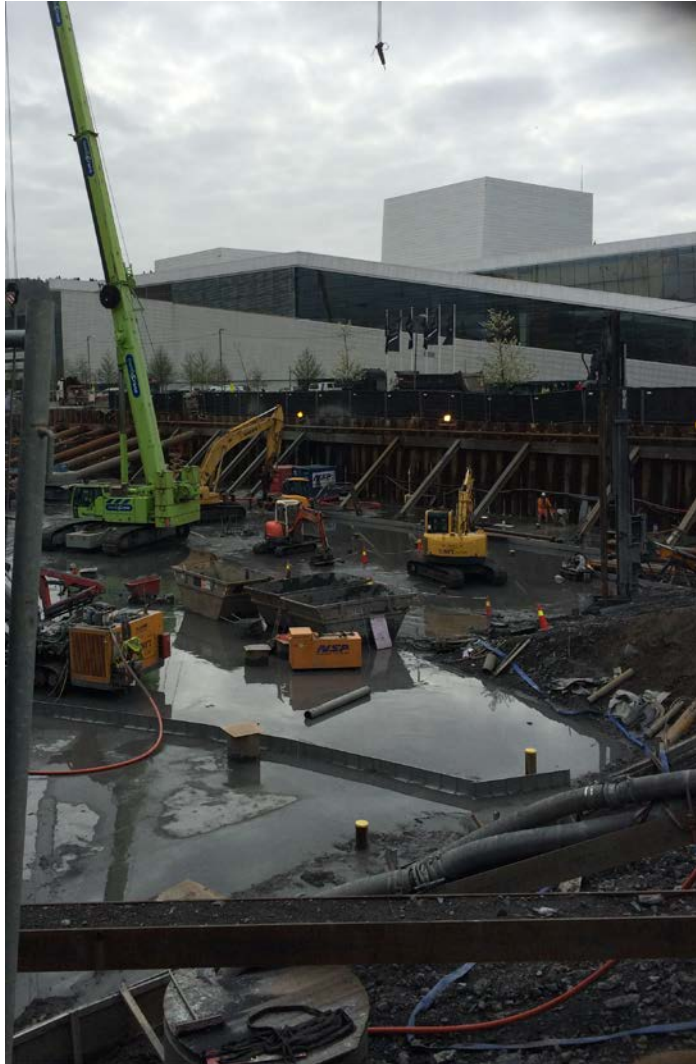
Byggegrøp for nye Deichmanske bibliotek.
