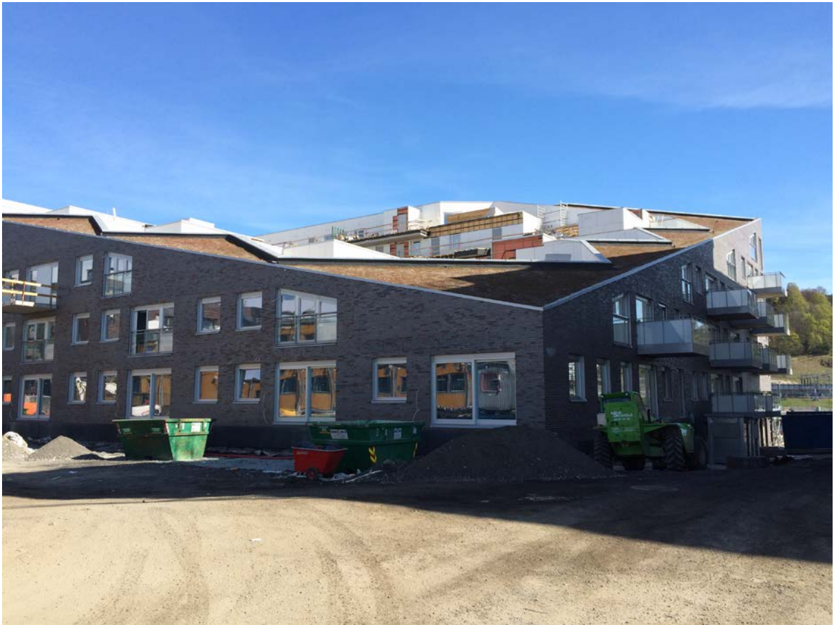
Bebyggelsen på felt D1b-4 på Sørenga. Sedum på taket.
