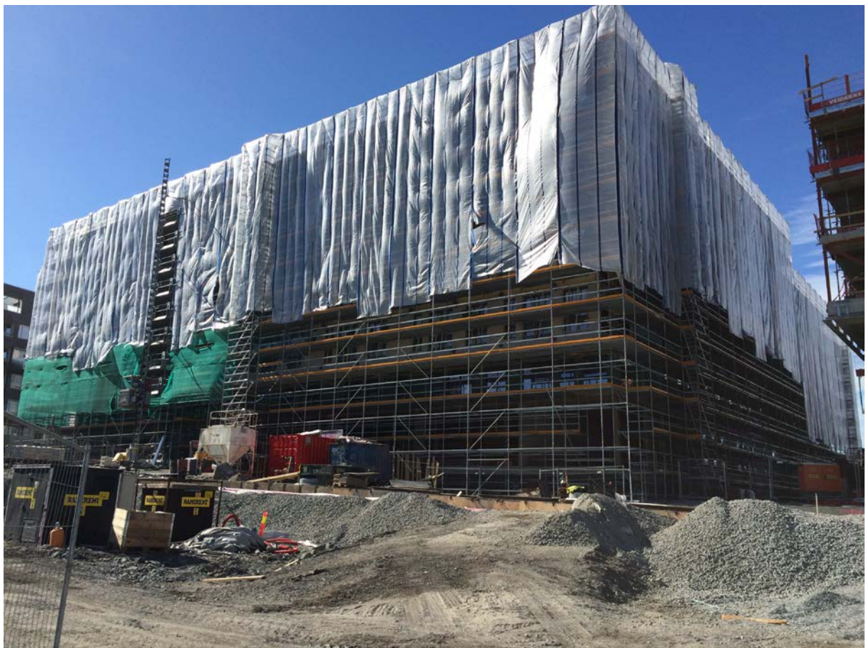
Byggeplassen på felt D1a.
