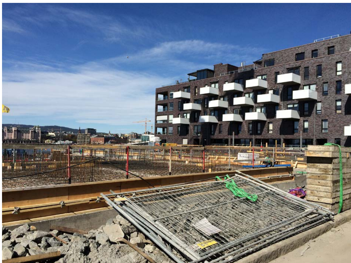
Bebyggelsen på felt D1b-8 på Sørenga på vei opp. Pågående betongarbeider.
