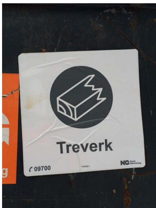
Kildesortering av byggavfall under arbeidet med Akerselvallemeningen.
