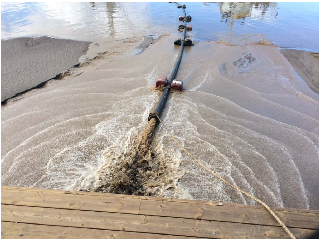
Utlekking av sand på den nye stranda på Sørengutstikkeren.
