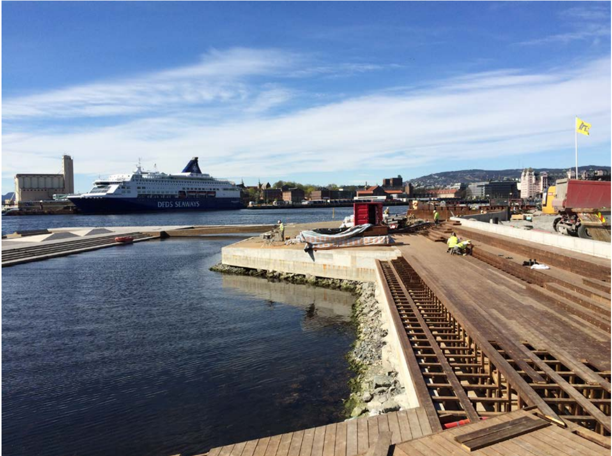
Det nye badeanlegget på Sørenga under oppføring. Brygger av kebony. Rett før utlegging av sand på stranda.
