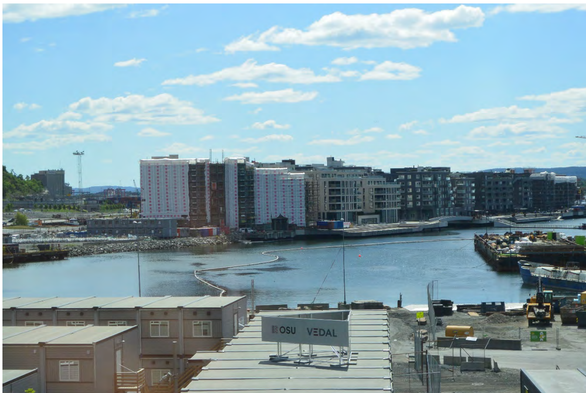
Bispevika. Vi ser siltgardiner i sjøen som forhindrer partikkelspredning fra Munch-prosjektet
