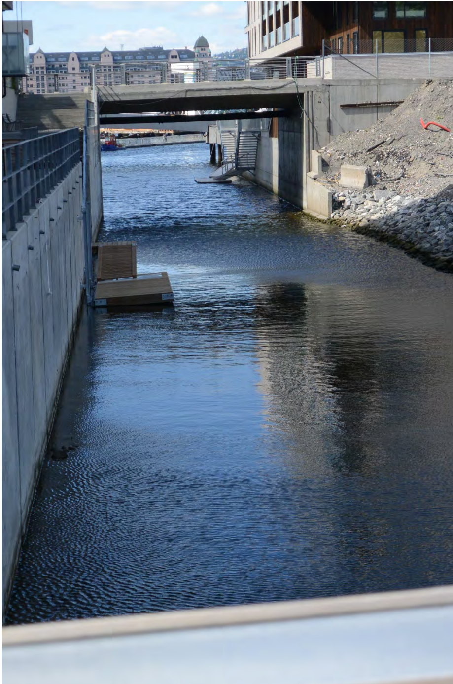
Det er etablert et kunstig fiskerev i bunnen av denne kanalen på Sørenga. Revet er bygget opp av gjenbruksbetong fra en kai i området som måtte rives
