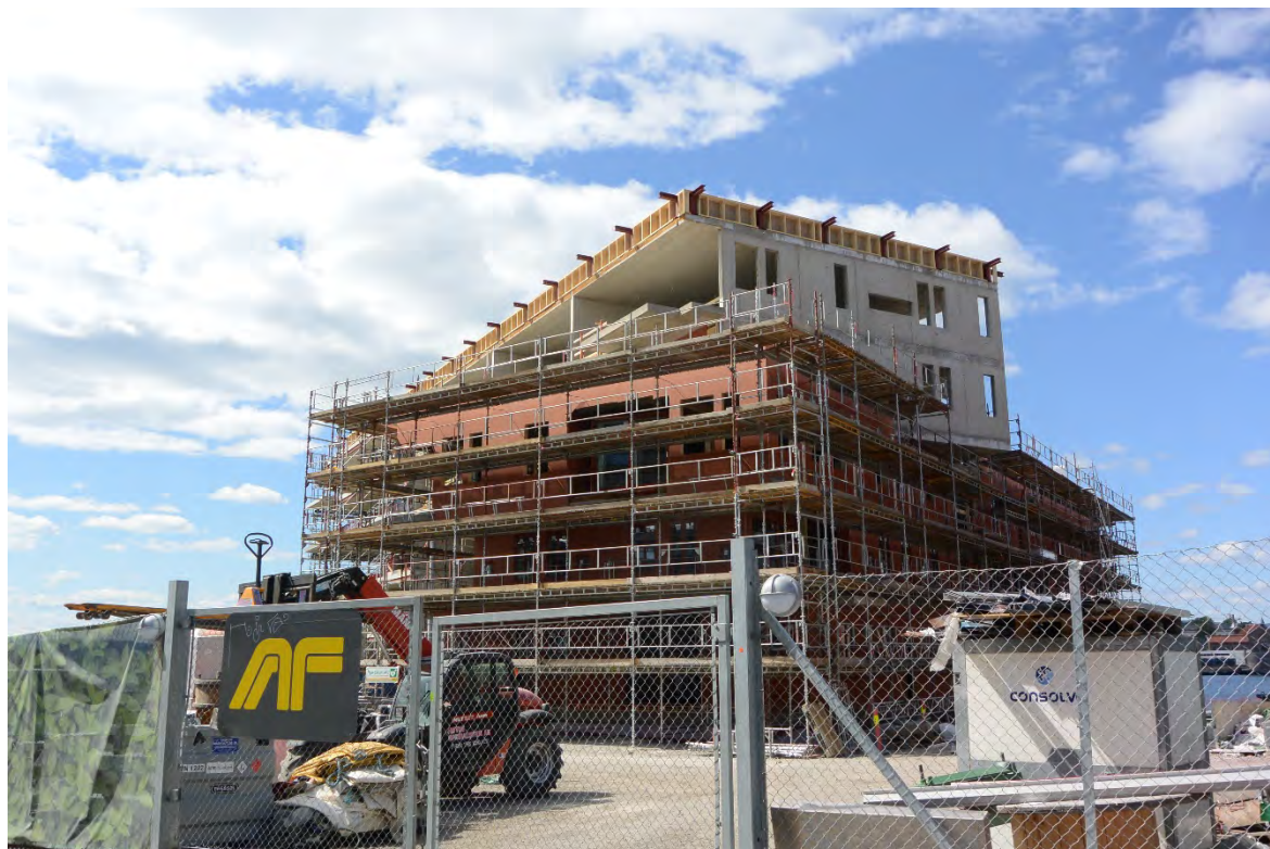
Siste byggetrinn på vei opp på Sørenga
