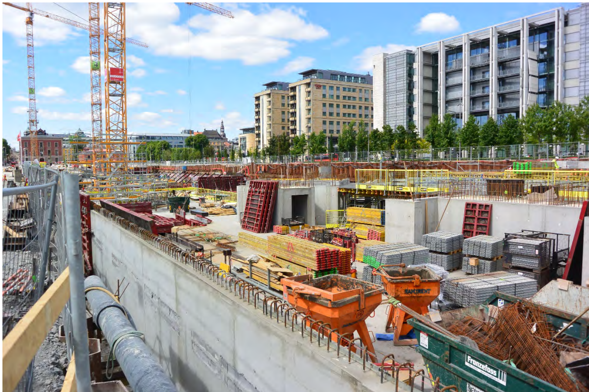
Byggegrøpa for A9 Diagonale i Bjørvika. Råbygg på vei opp
