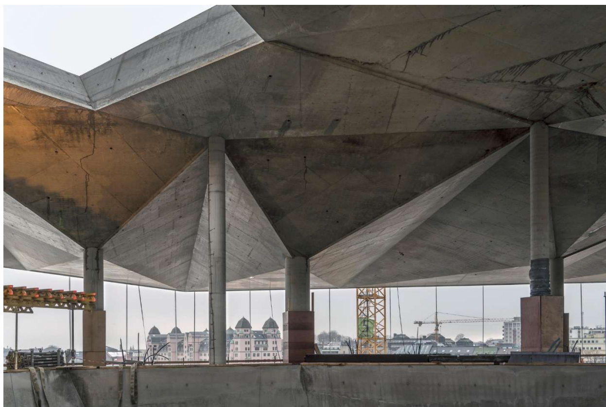
Plasstøpt dekke i Deichmanske bibliotek.
