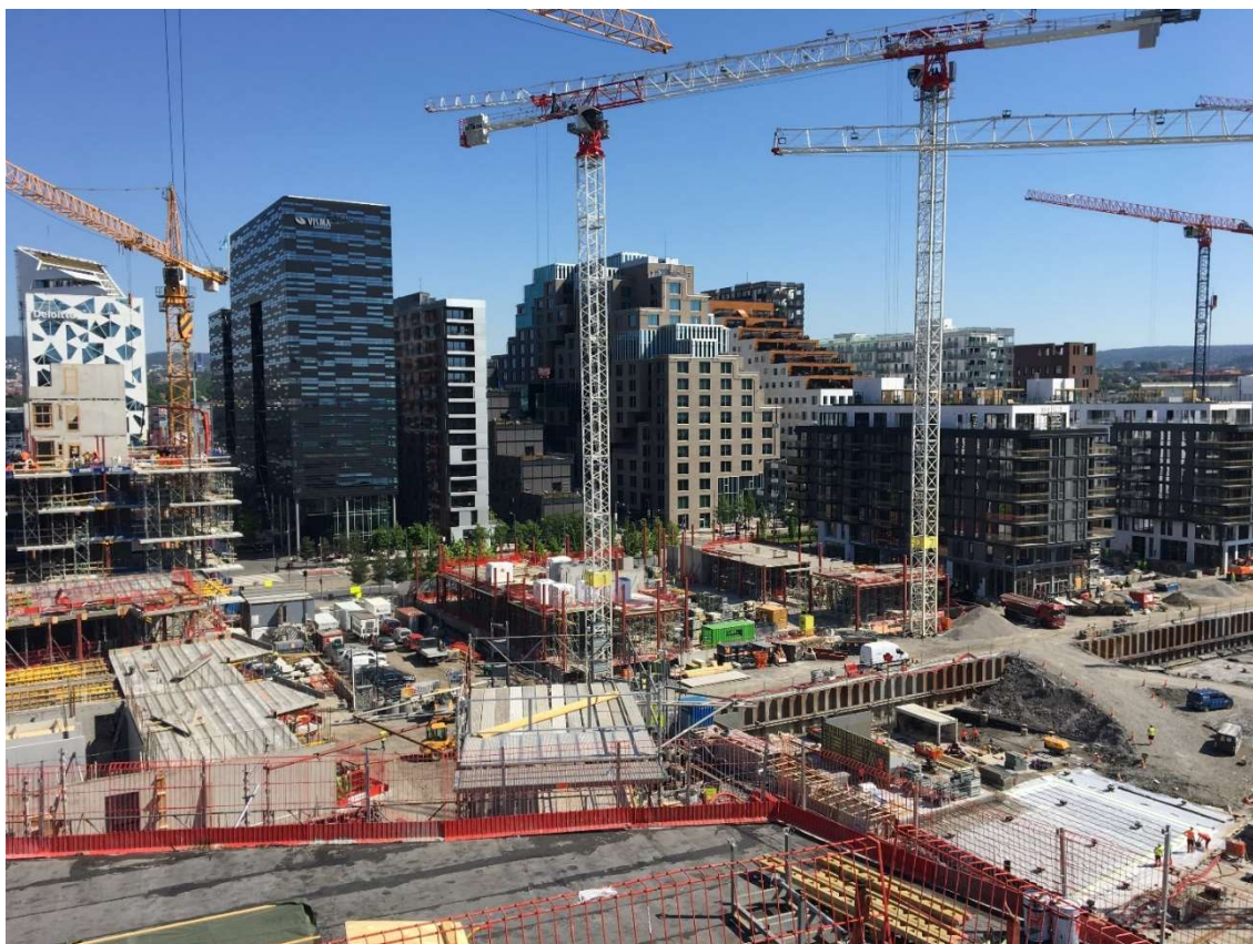
Utsikt fra Munch Brygge mot byggefelt B1, B2 og B3.
