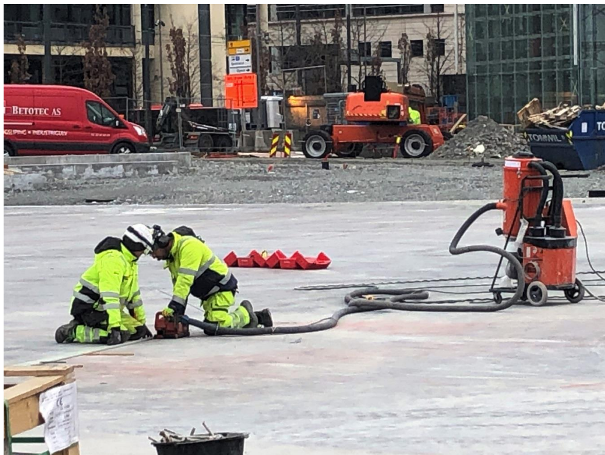
Pågående arbeider med nytt vannspeil i Operaallmenningen.
