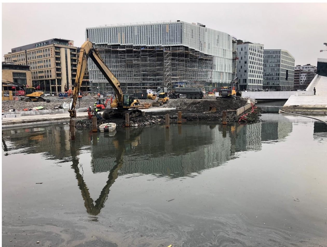
Utgraving som gjør om land til vann ved Operaallmenningen.
