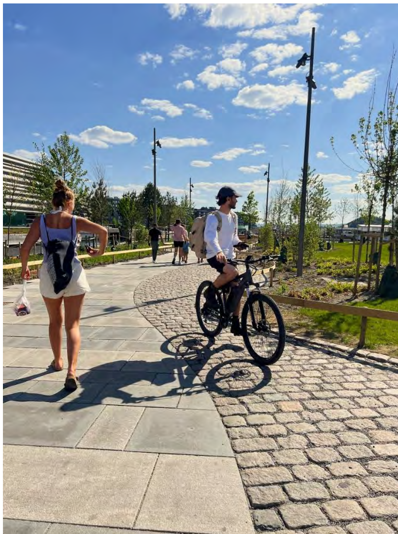
Avkapp fra tidligere anlegg og gjenbrukt stein som belegg i Akerselvallmenningen.
